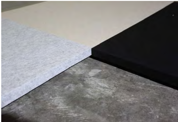
photo : détail lors de la construction, placement des panneaux 'SlimBox mur' sur des supports en bois, côte à côte
