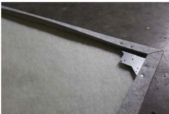
photos : arrière de l'ilôt du plafond, remplis avec le molleton acoustique
