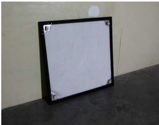
photo : Intérieur du panneau 'SlimBox mur' (1060 x 1060 x 42 mm) avec des support en bois avec une hauteur de 30 mm
